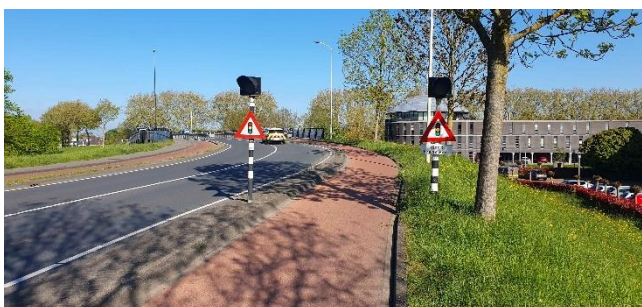
Fiets over de Lingebrug
