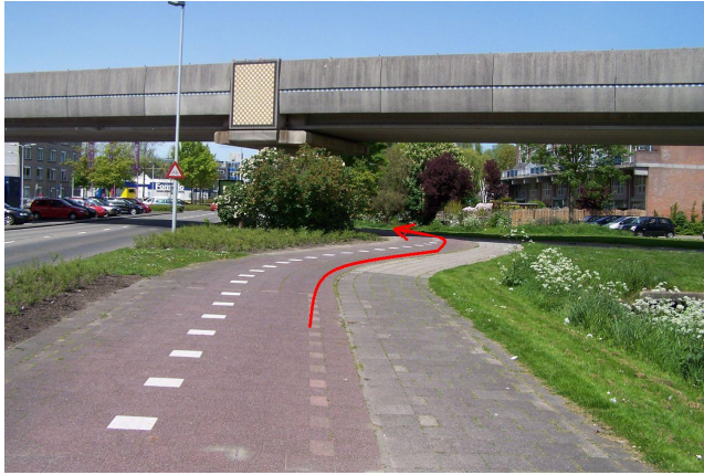
Fiets rechtdoor onder het spoorviaduct door
